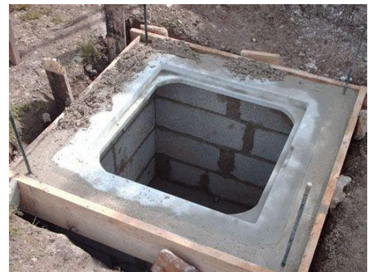
Réaliser un regard en parpaings
